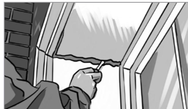
Рис. 9. Между собой фасадные элементы стыкуются посредством клея-пены
