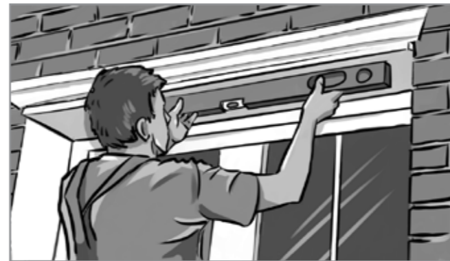
Рис. 8. Проверка правильности положения приклеенного элемента
