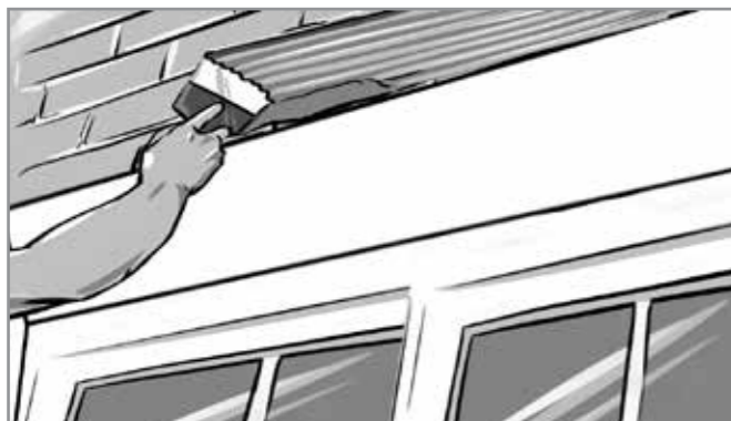
Рис. 5. Нанесение монтажного клея на несущую поверхность.
